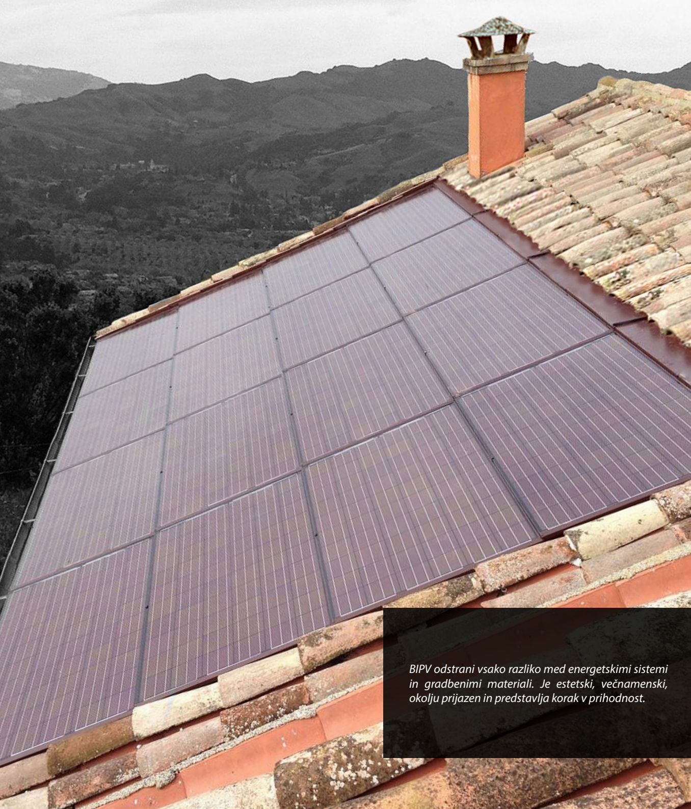
Detajl posebnega okvirja BIPV (Solrif®)
